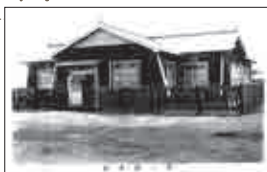
第一仮本館(『横浜市図書館概要』より)
