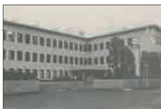
港北図書館(『横浜市のとしよかん'84』より)
